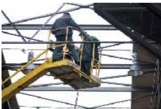
фото: чтобы достать пресс из производственного цеха, нужно было разобрать крышу цеха
