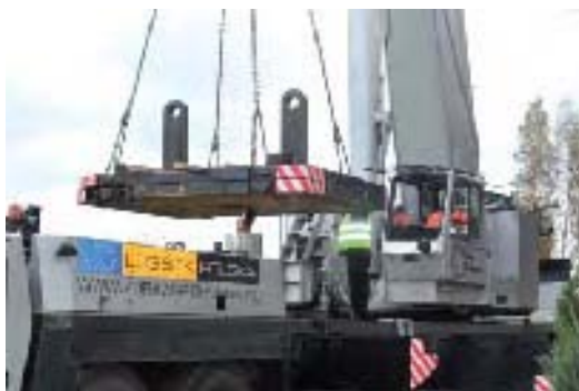
фото: оснастка крана
