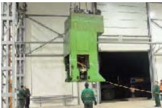
фото: установка 65-тонного пресса требует точности и общей осторожности
